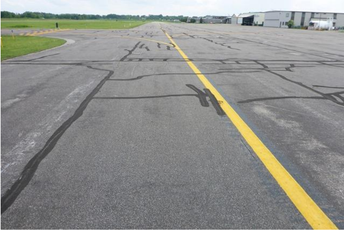
CFE PTA 002 (PCI = 72)
