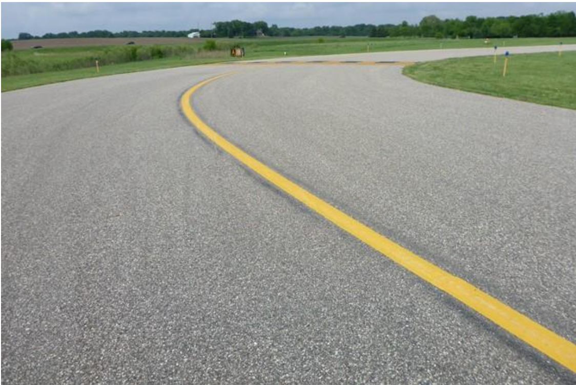
CFE PTA 001 (PCI = 94)
