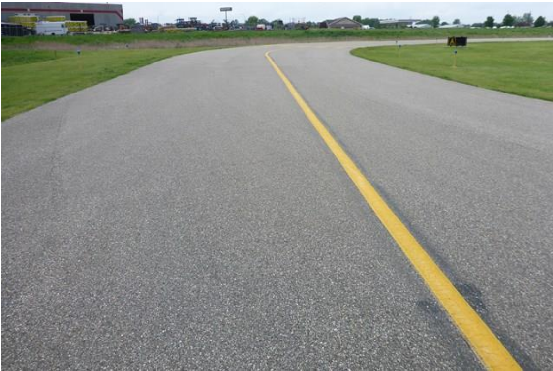
CFE PTA 003 (PCI = 95)
