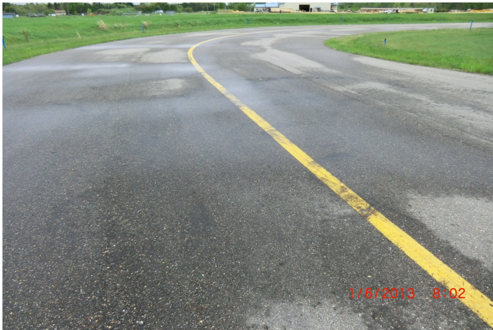
PWC PTA 002 (PCI = 89)
