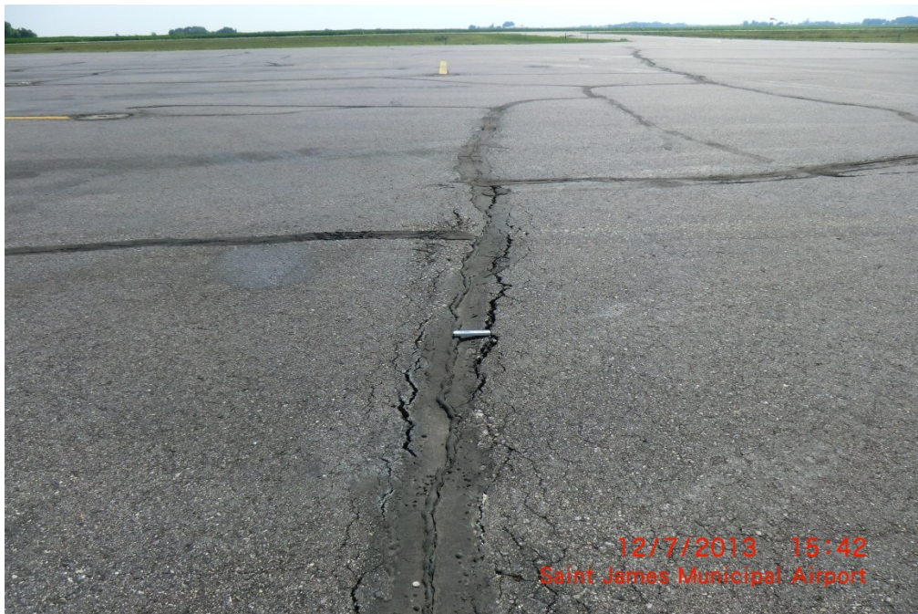
JYG APA 001 (Medium-Severity L&T Cracking)
