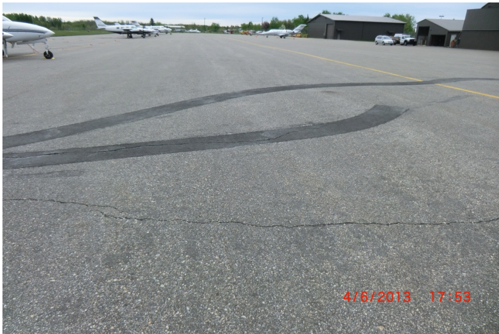
INL APB 001 (PCI = 85)
