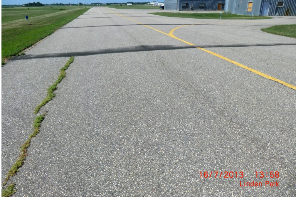
HCD PTA 002 (PCI = 71)
