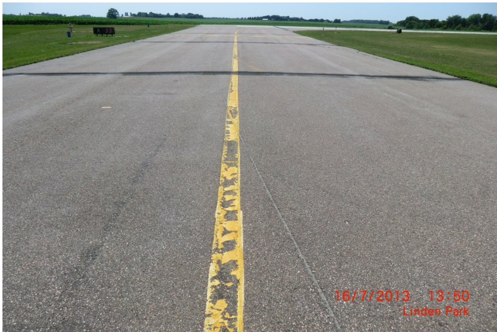
HCD PTA 001 (PCI = 73)
