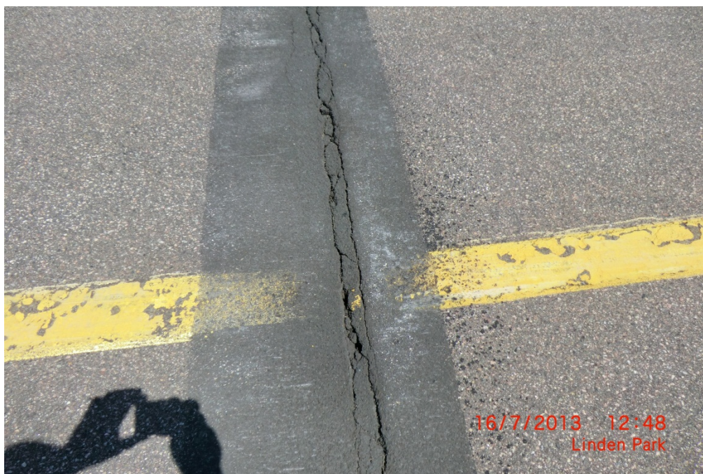
HCD RY1533 001 (L&T Crack Repair)
