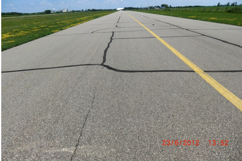
BBB PTA 001 (PCI = 70)
