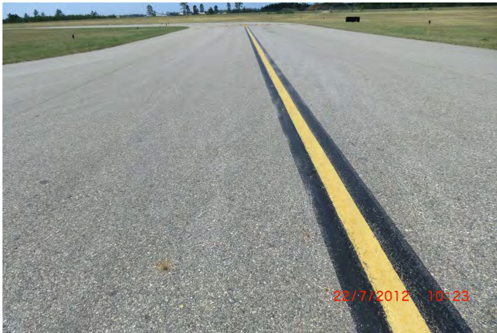
BJI PTA 001 (PCI = 97)
