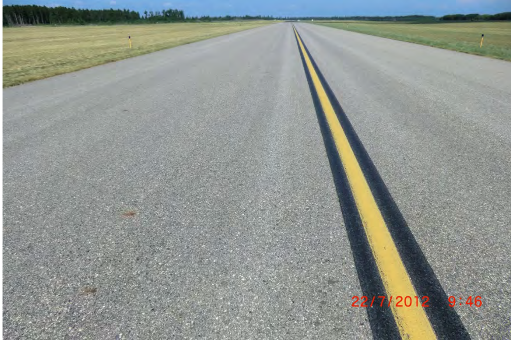
BJI PTA 002 (PCI = 90)
