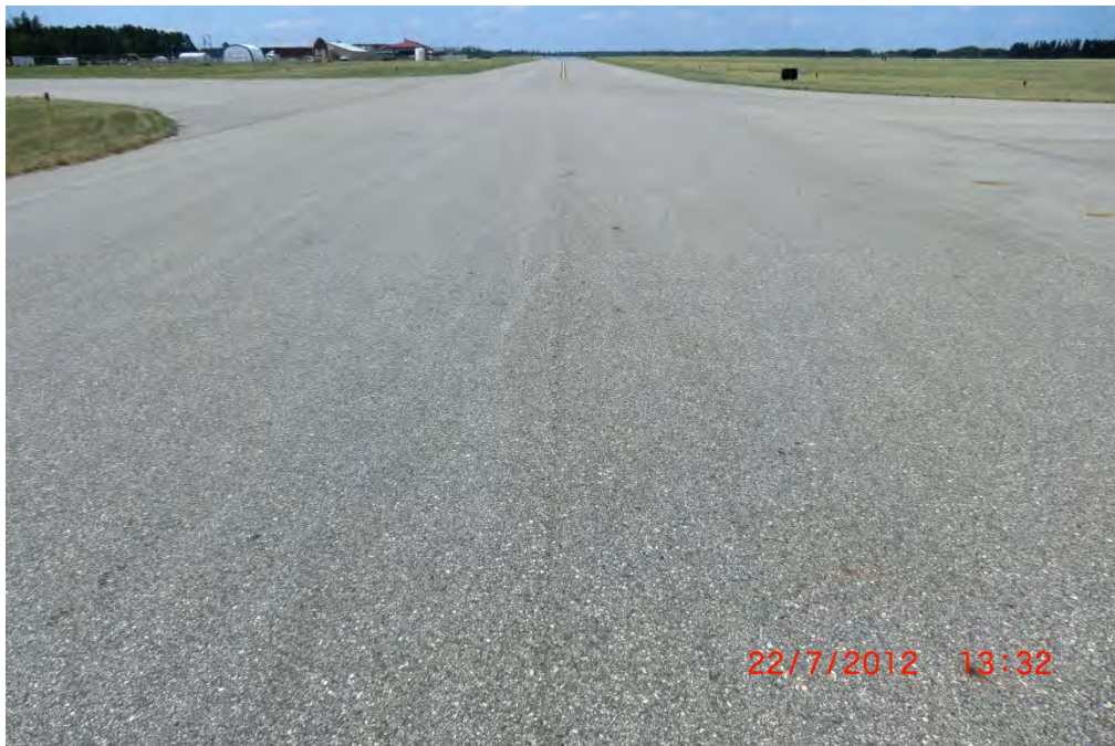
BJI PTA 002 (PCI = 90)
