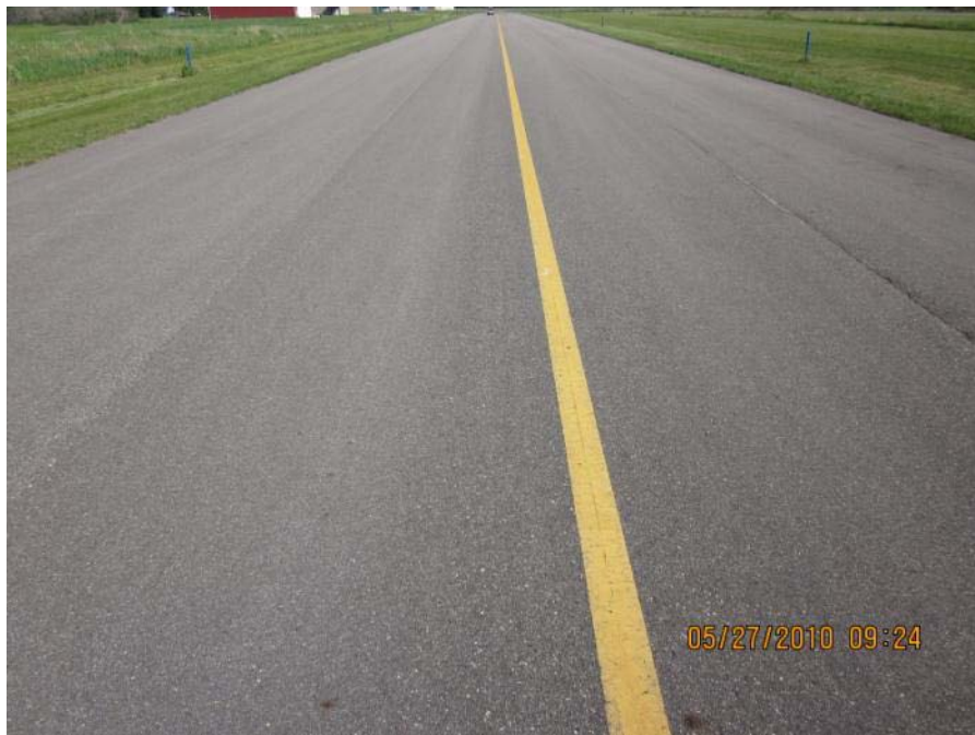
PWC PTA 001 (PCI = 91)
